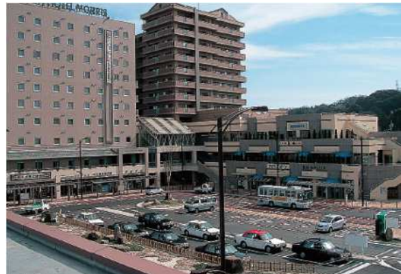
益田駅前地区第一種市街地再開発事業（益田市）
