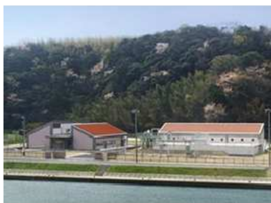
国府浄化センター（浜田市）
