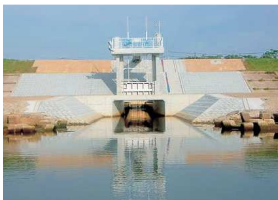
万葉都市下水路樋門（益田市）
