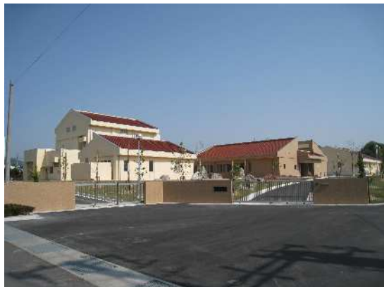
大田浄化センター（大田市）
