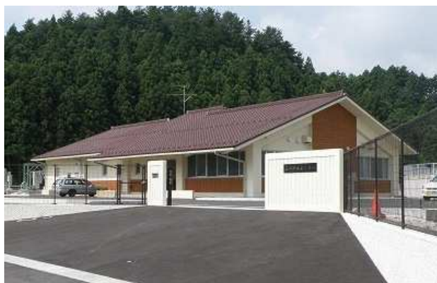
西郷浄化センター（隠岐の島町）
