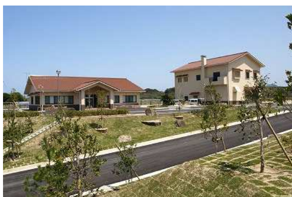
益田水質管理センター（益田市）
