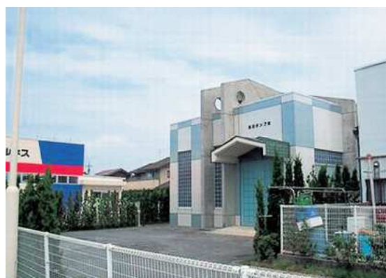
黒田中継ポンプ場（松江市）
