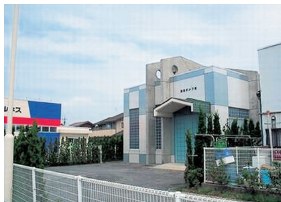
黒田中継ポンプ場（松江市）
