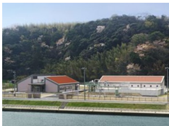
国府浄化センター（浜田市）
