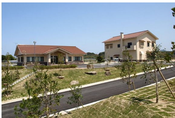
益田水質管理センター（益田市）
