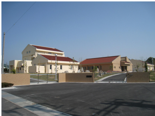
大田浄化センター（大田市）
