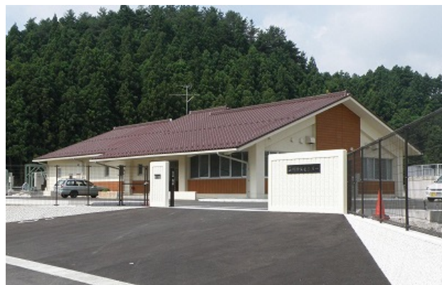
西郷浄化センター（隠岐の島町）
