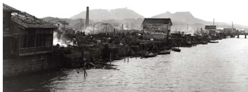
大火の翌日の様子(大橋より初代新大橋を望む)
