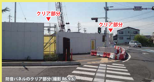
防音パネルのクリア部分(撮影 R6.9.6)
