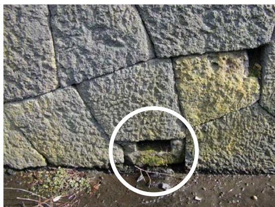
島石の石積の中につくられた来待石の排水溝
