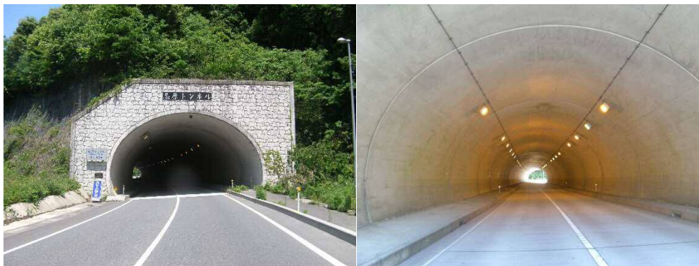
国道375号 忍原トンネル (R2年度完了)
