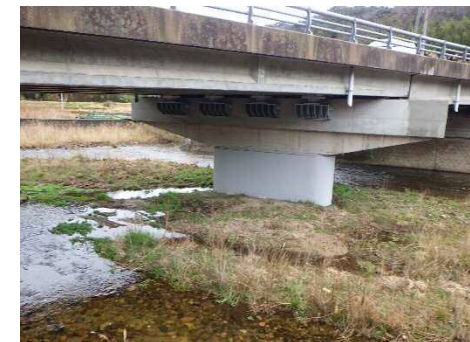
令和4年度完了 橋脚部
