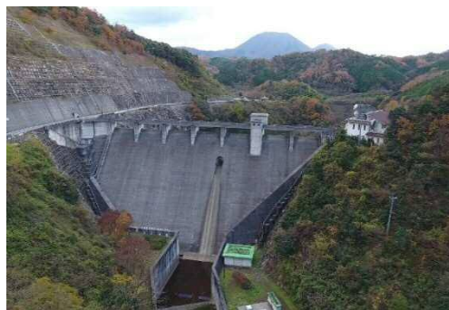
三瓶ダム本体全景
