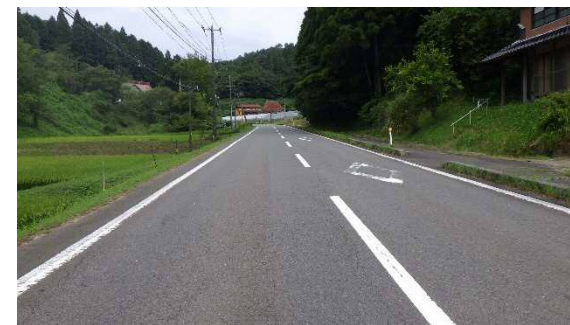
（主）温泉津川本線（井田工区） R5予定
