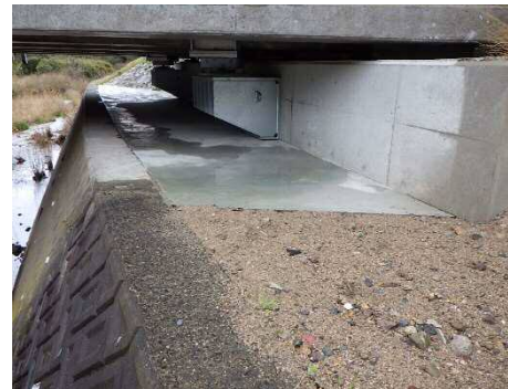
令和4年度完了 橋台部
