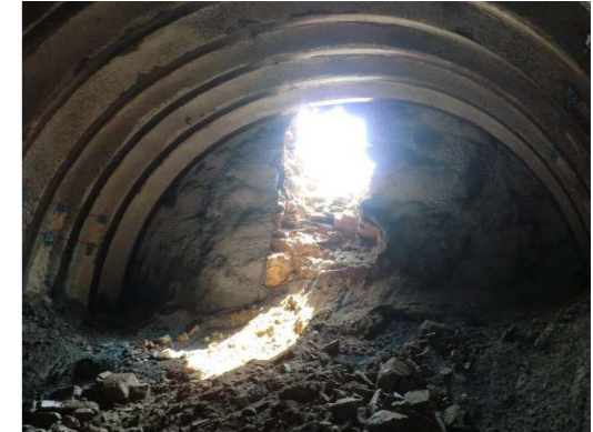
トンネル貫通状況
