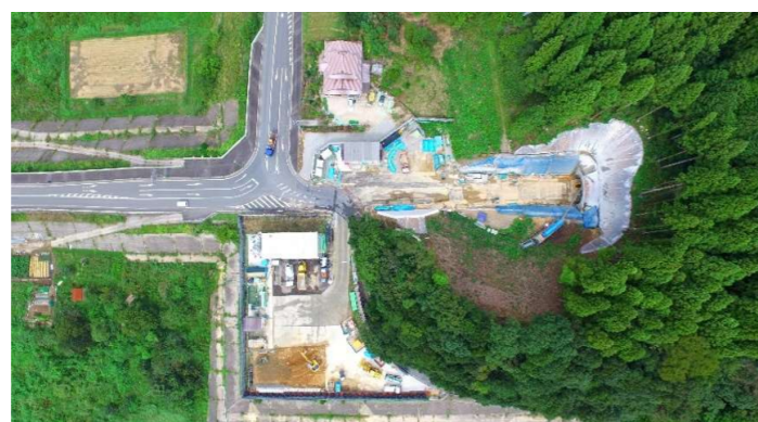
多田側坑口付近(ドローンで空撮)
