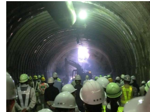
トンネル貫通状況
