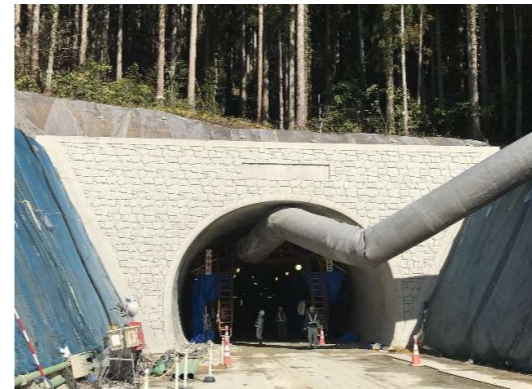
トンネル多田(川本町)側坑口
