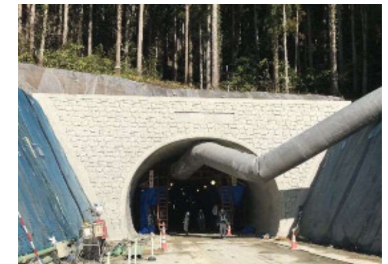
トンネル多田側坑口(H31年1月末)
