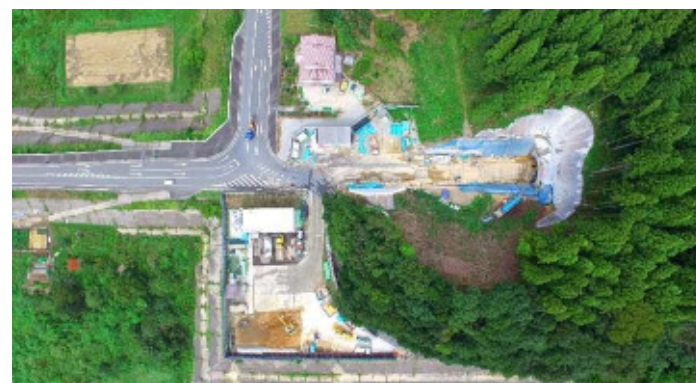
多田側坑口付近(ドローンで空撮)
