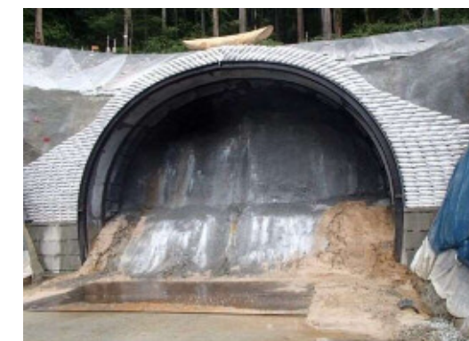
トンネル多田側坑口(H30.9月)
