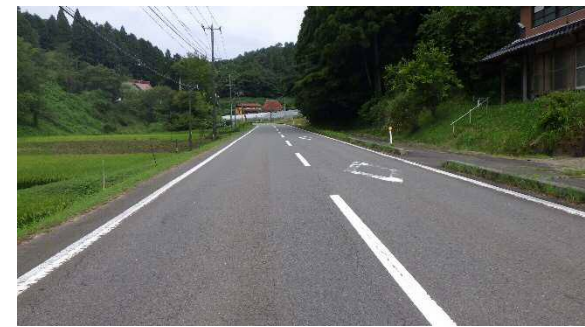
（主）温泉津川本線（井田工区） R5予定
