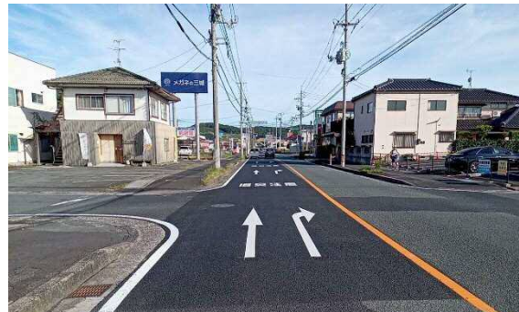
国道375号（山崎工区） R4完成
