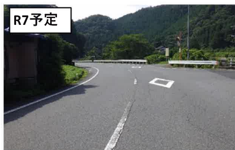
（主）三瓶山公園線（野城工区）
