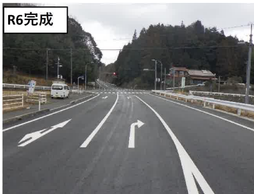
（主）仁摩邑南線（水上工区）
