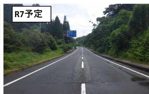
（主）仁摩邑南線（水上工区）
