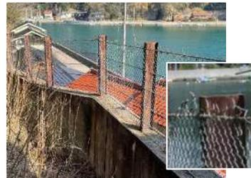
補修前（網破損、錆）
