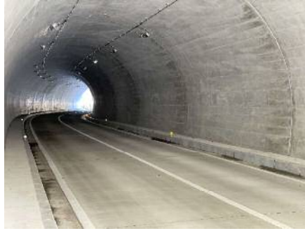
トンネル坑内
