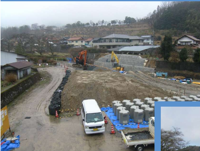
▲仮設ヤードの状況
