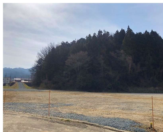
▲旧今市小学校の解体工事完了！ (浜田市工事)
