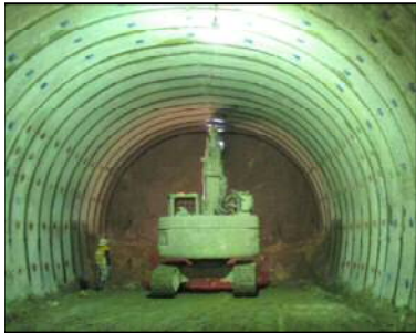
大型フレッカーで掘削すると・・・
