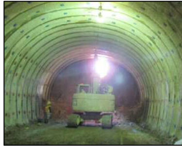
貫通したところから眩しい光と同時に風がトンネル内に吹き込んできました
