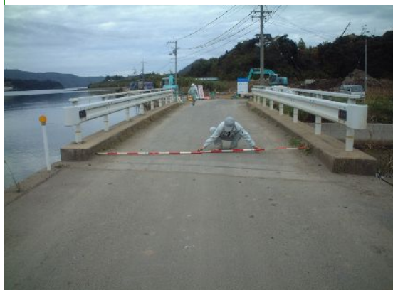
橋梁 整備前写真
