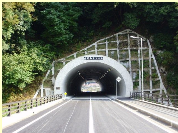
宮尾山トンネル
