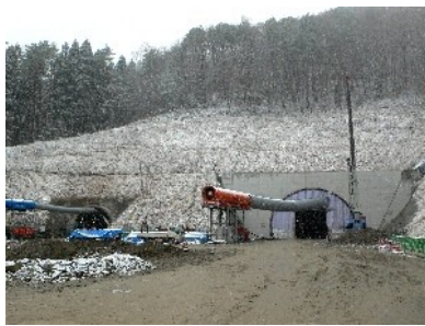
広島県側からも掘削作業が進む大万木トンネル L=4878m(庄原市内)
