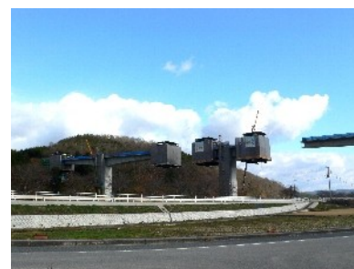
張出架設により上部工事が進む馬洗川橋 L=696m(三次市内)
