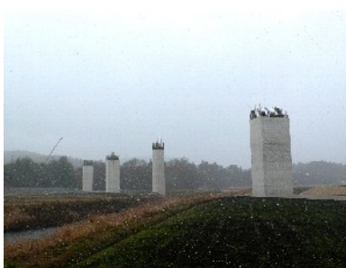
橋脚が立ち並ぶ下門田橋 L=530m この先が高野 IC(庄原市内)
