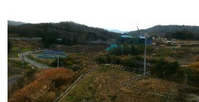
中国道の跨道橋の架設が終わった三次 JCT 周辺(三次市内)
