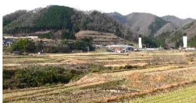
整備が進む口和 IC 周辺 写真右は竹地川橋 L=297m(庄原市内)
