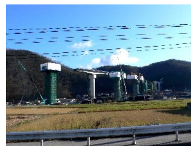
国道 184 号からのぞむ海田原橋 L=674m 手前が吉舎 IC(三次市内)
