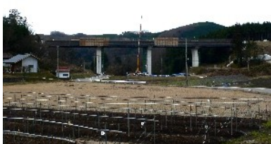
PC 上部工事が施工中の常定橋 L=133m(庄原市内)
