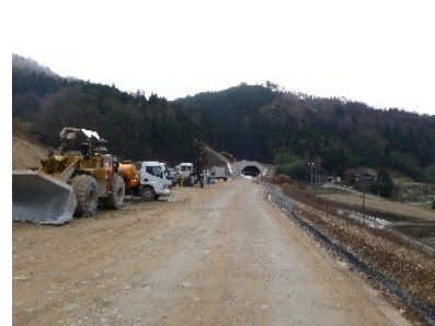
路体面まで仕上がった上本谷トンネル L=680m の周辺(庄原市内)
