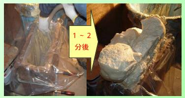
空洞に入れるのは、硬質発砲ウレタンです。これは、2 つの液を混ぜて作る発泡スチロールのようなものです。混
