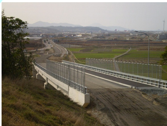
沖手高架橋完成状況 1
