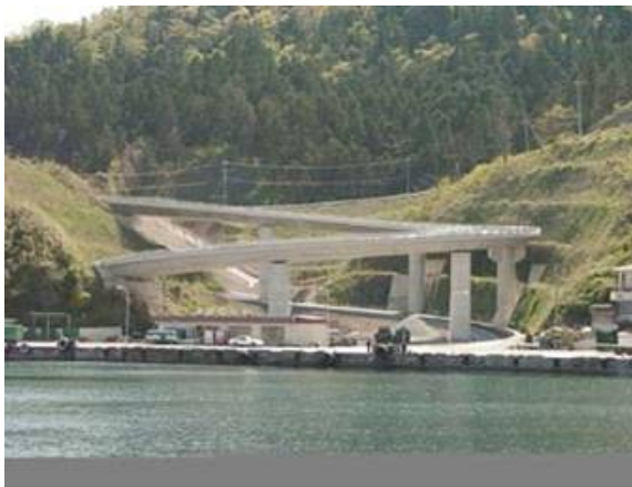
海側から望んだ知夫里大橋（ループ橋）
