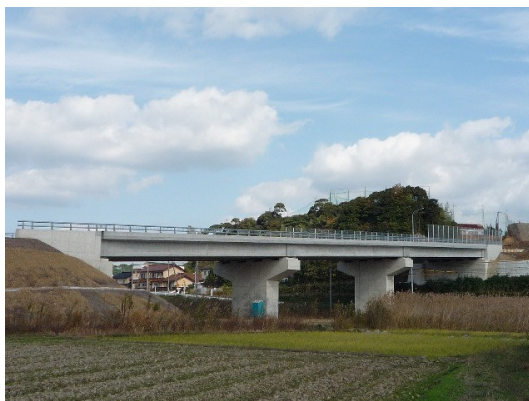
沖手高架橋完成状況 2
