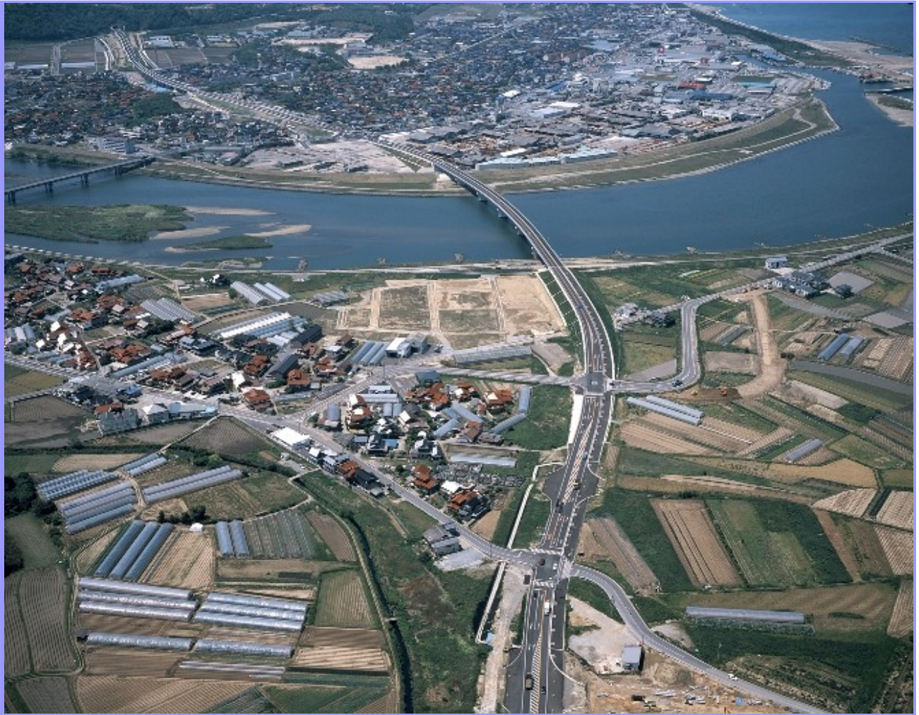
一般県道 久城インター線 (益田市高津町～久城町)
