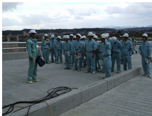
沖手高架橋の施工状況を見学
