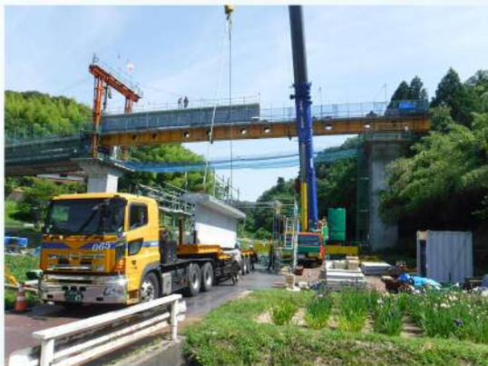
400t 吊クレーンにて5分割した橋桁を吊上げるところ
