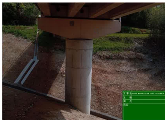
橋脚 RC 巻立（施工後）
