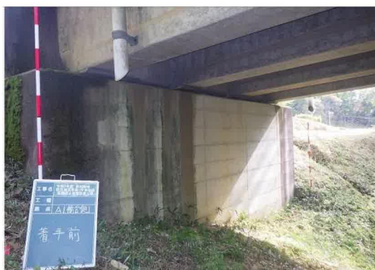
落橋防止装置（施工前）
