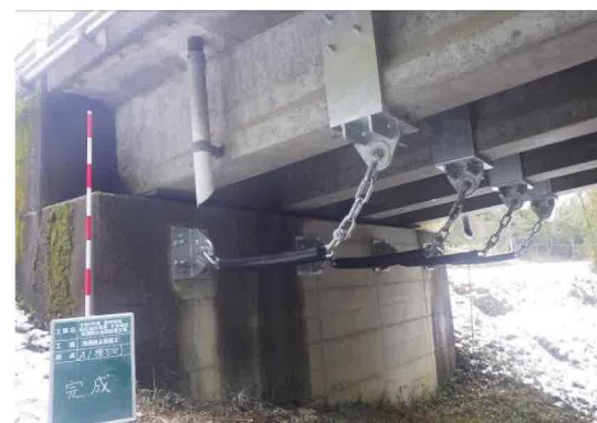
落橋防止装置（施工後）
