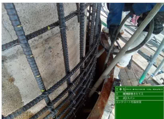
橋脚 RC 巻立（施工状況）
