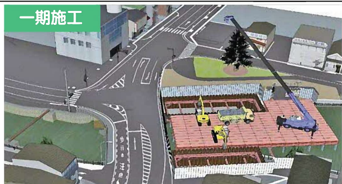
下流側の既設橋梁の歩道部分を撤去し、新しい橋を設置します。
