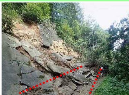
地すべり末端部の押し出し
