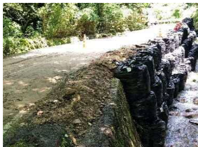
応急工事完了
