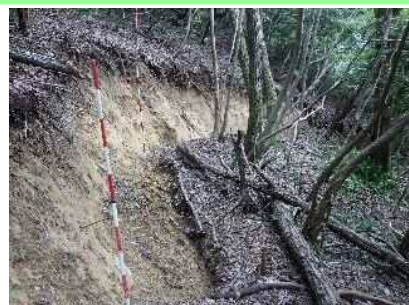
地すべり頭部の滑落崖
