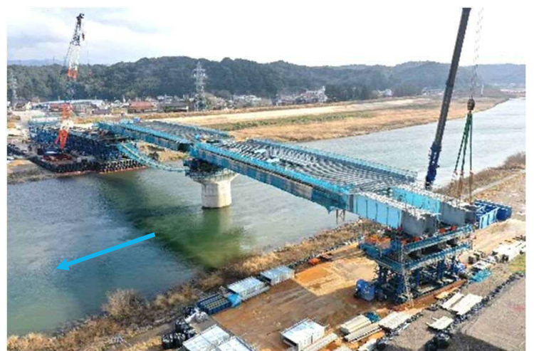
送り出し架設完了
