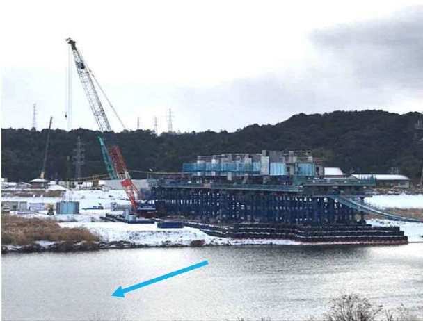
送り出し準備（桁の組立作業）
