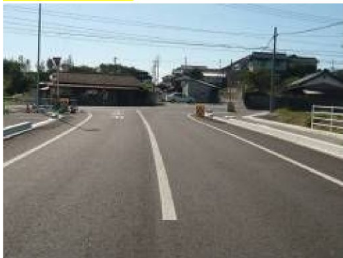
第二期整備区間
