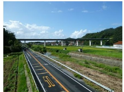
(3)福光 IC(仮称)近くの福波第2高架橋(仮称)
