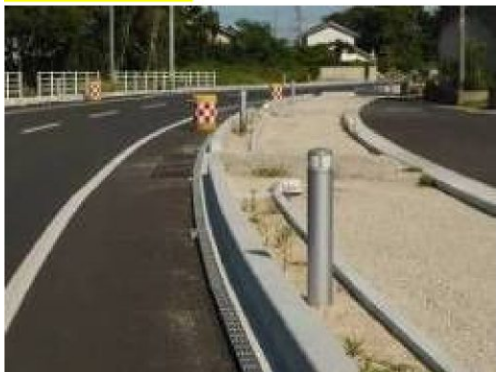
第二期整備区間
