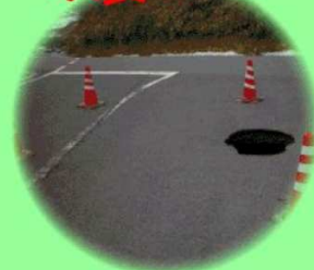
舗装の陥没
