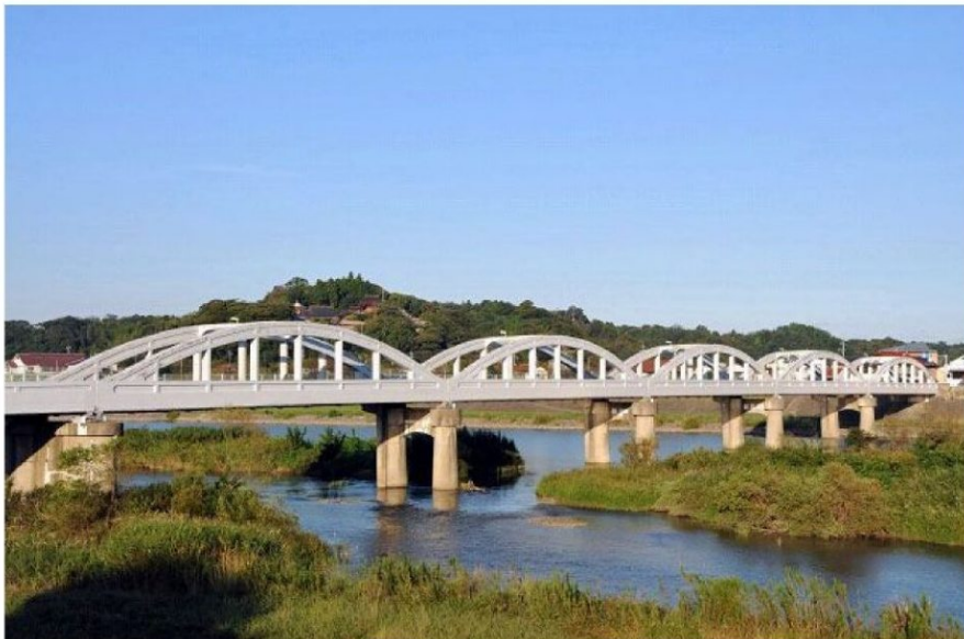
【写真】高角橋（高津川下流より）
