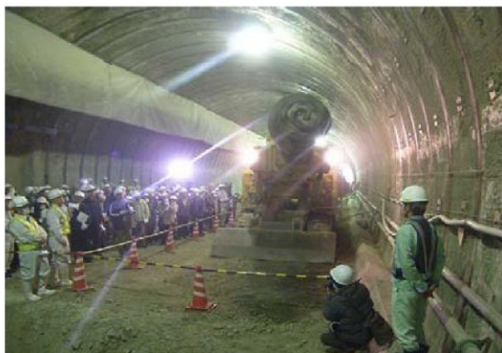
グイーン！モグラのようなトンネル掘削機
