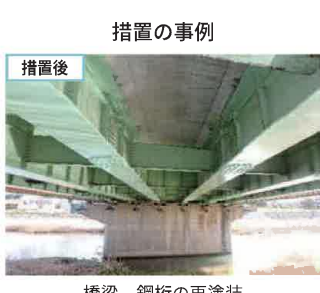
措置の事例 橋梁 鋼桁の再塗装
