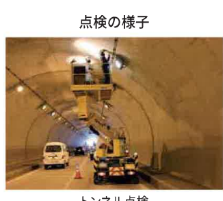
点検の様子 トンネル点検
