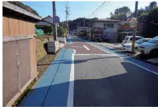
(一)池田中町線(隠岐の島町)
