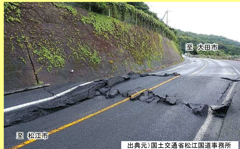
出典元) 国土交通省松江国道事務所
