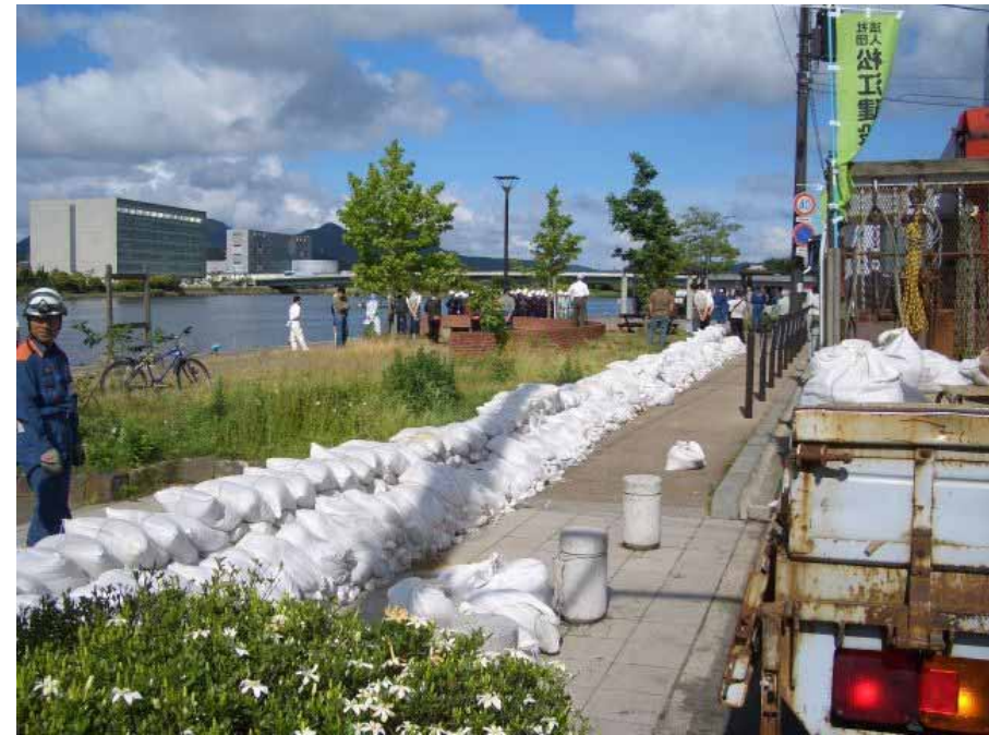
H18.7越流箇所での土のう設置訓練
