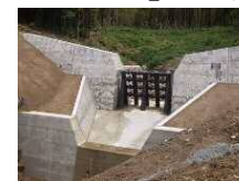
砂防えん堤工
