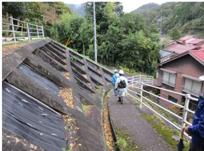
急傾斜地崩壊防止施設点検の様子
