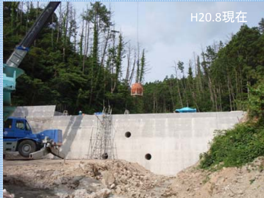
本川上流に砂防えん堤を施工中
