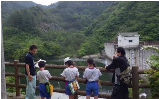
【実際にダムを見ながら説明を受ける様子】
