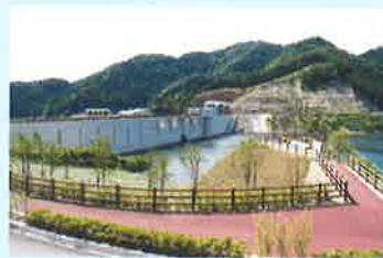
ダム堤体左岸広場
