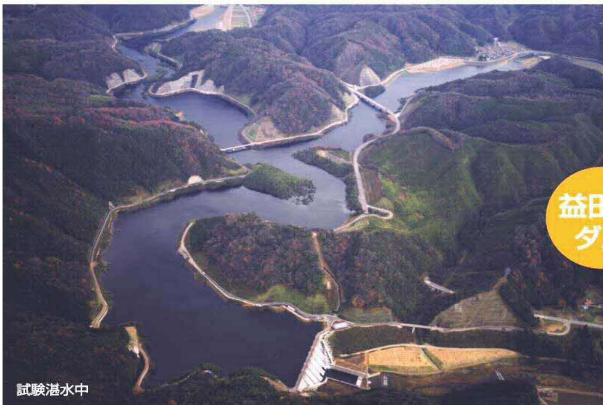
益田川ダム完成写真 (試験湛水中)
