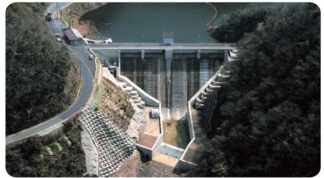
笹倉ダム [平成19年3月完成]
