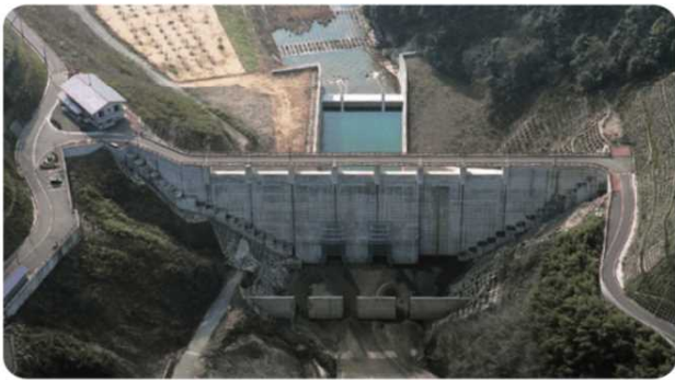
益田川ダム [平成18年3月完成]
