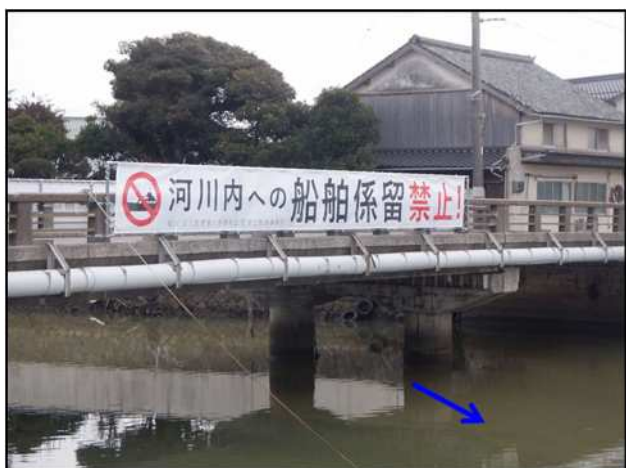
流下橋下流より
