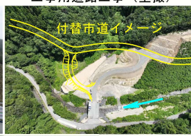
付替市道をつくるための 工事用道路工事(空掘)
