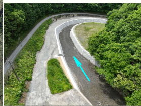
護岸工事完成(次は道路の拡幅)
