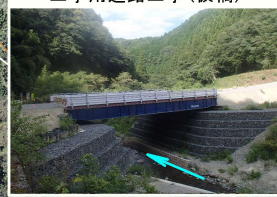
付替市道をつくるための 工事用道路工事(仮橋)
