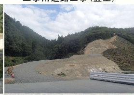
付替市道をつくるための 工事用道路工事(盛土)
