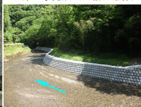
右岸工事完成(川幅の確保)
