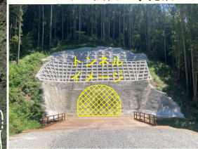
トンネル法面工事完成
