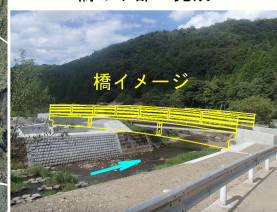
橋の下部工完成
