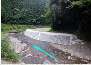
道路拡幅のための川幅の確保
