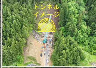
トンネル前の橋を架ける工事
