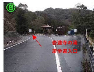
付替林道終点部
