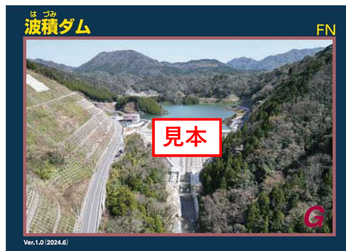
新ダムカード
