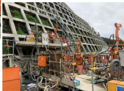
この機材を使ってセメントミルクを注入し、岩盤の改良を行っています。
