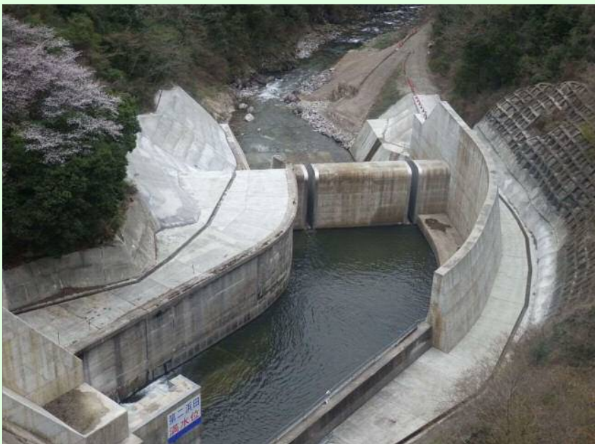
減勢工・工事用道路
