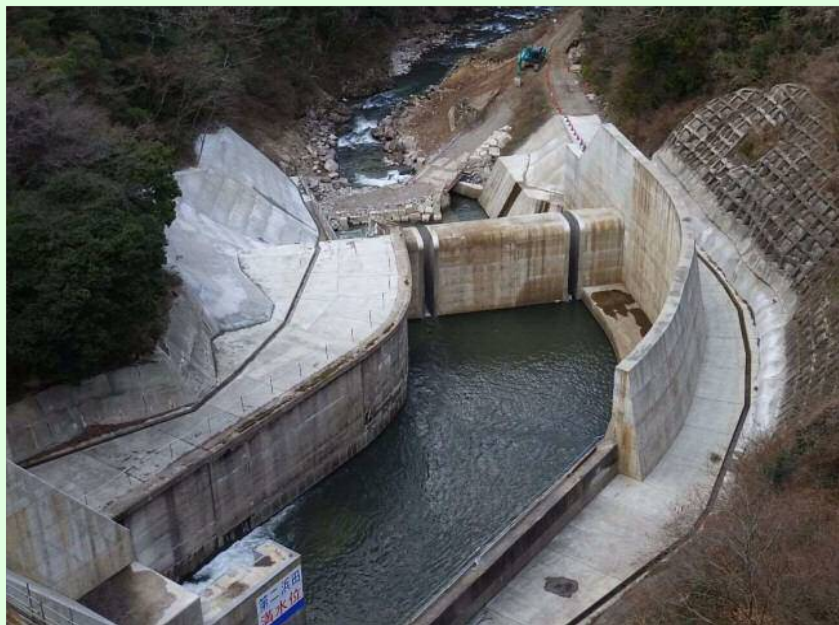
減勢工・工事用道路
