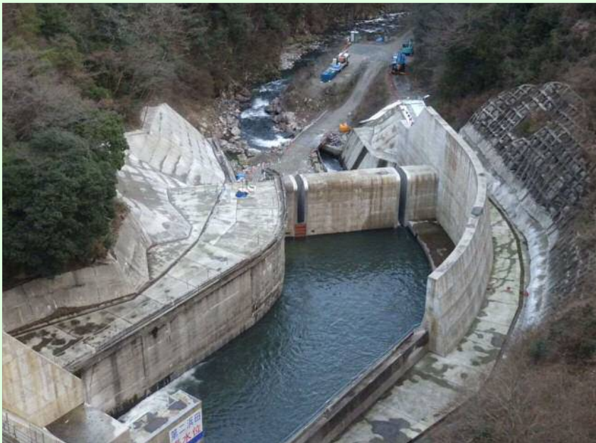
減勢工・工事用道路
