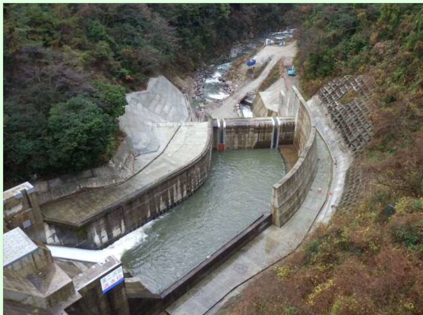
減勢工・工事用道路
