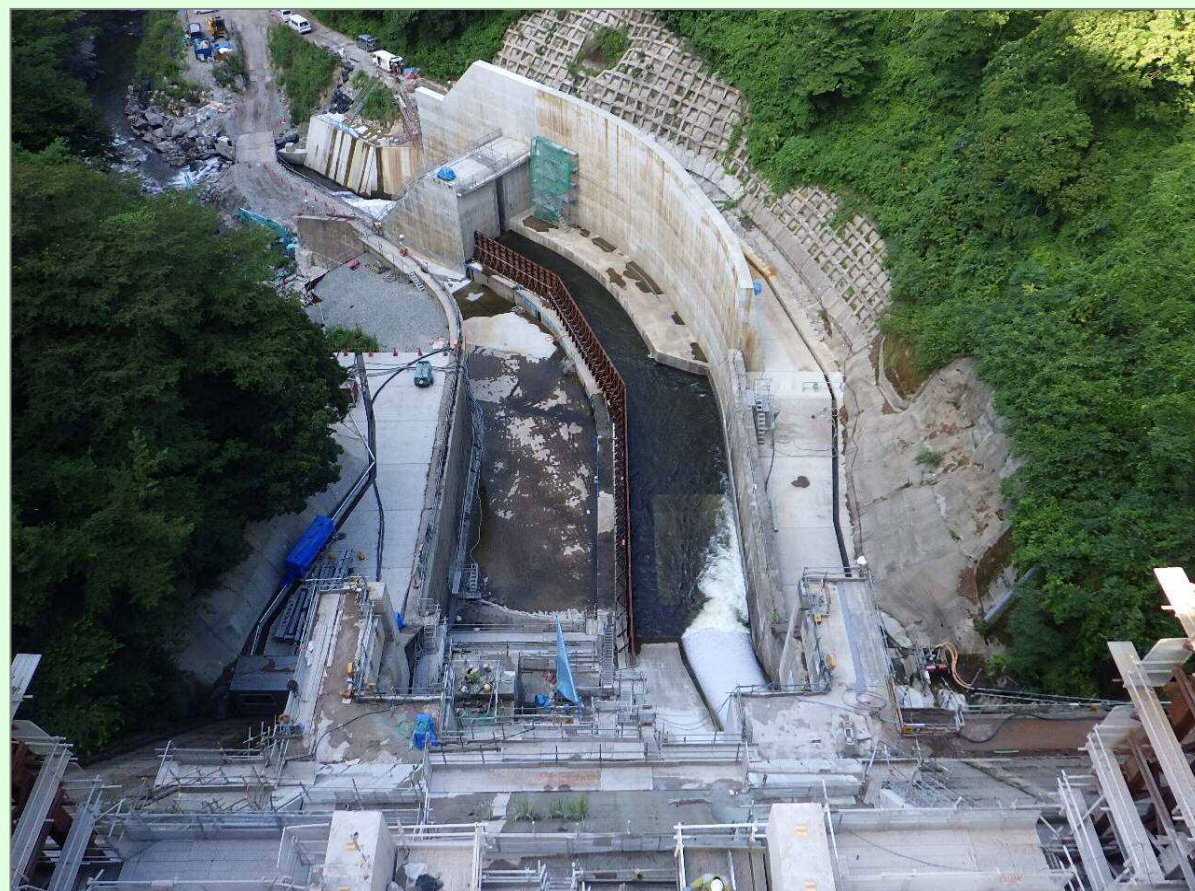
減勢工・工事用道路
