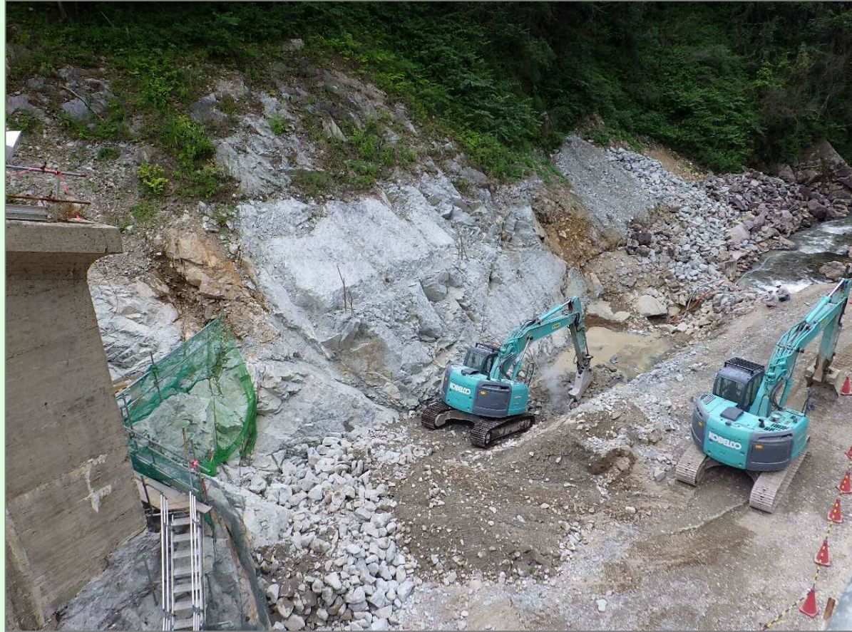
減勢工施工状況
