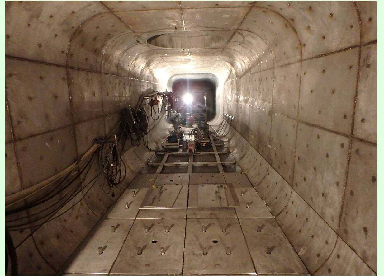
放流管ライニング施工状況
