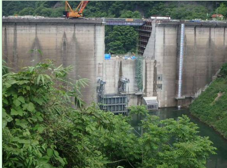
上流仮締切施工状況
