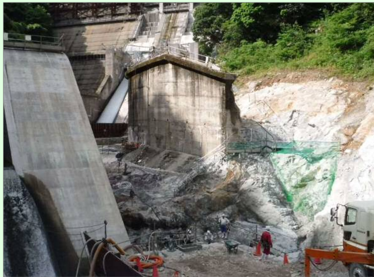
減勢工施工状況
