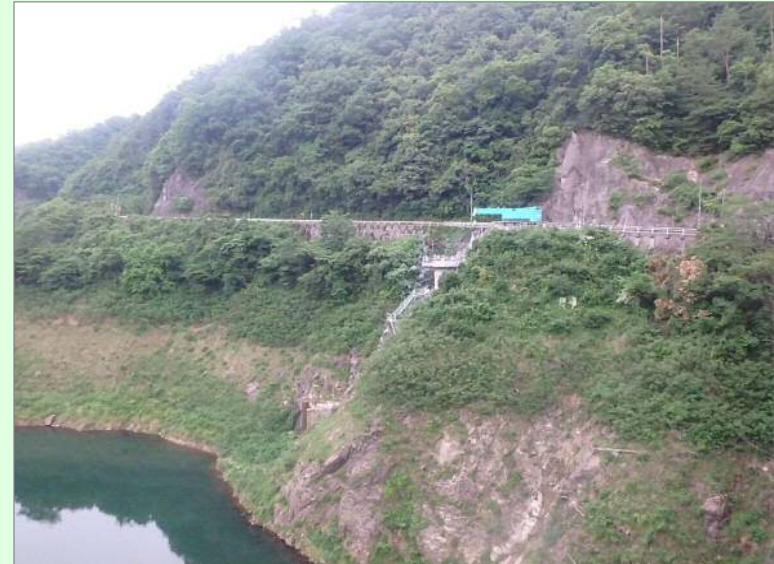
取水塔撤去施工状況
