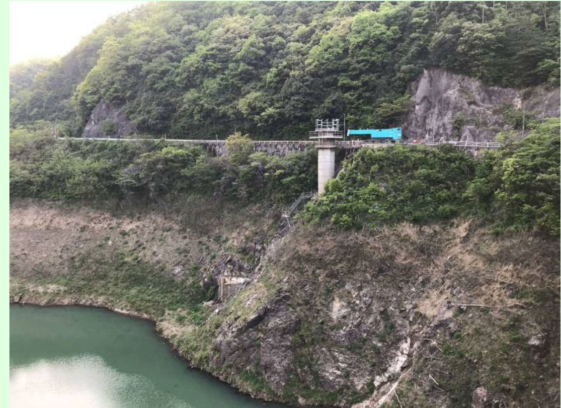
取水塔撤去施工状況
