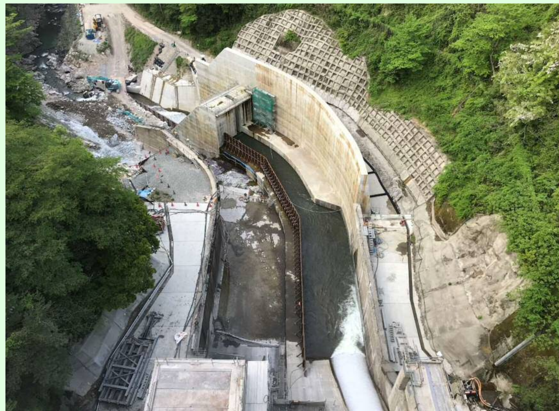
減勢工・工事用道路
