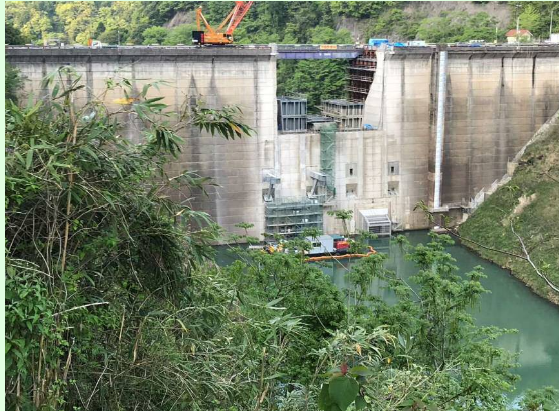
上流仮締切施工状況
